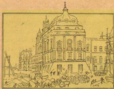
Construção do Convento de Mafra, o maior edifício de Portugal, em que D. João V dispendeu parte das riquezas do Brasil
